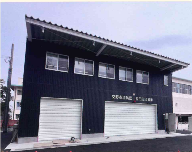
新しい星田分団の集会室・車庫の外観
