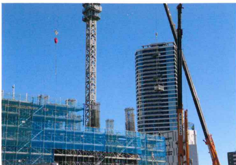
耐震性が確保されていないマンションは、見捨てられるマンションになっていきます。
