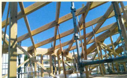
互いに支持し合うことでバランスを保つレシプロ梁を用い、柱と梁を組み合わせることで建物を支える構造です。
