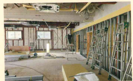
工事監理とは、建築主の立場に立って、工事が設計図書どおりに実施されているかを確認する業務です。
