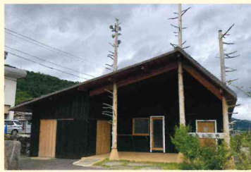
2021年6月竣工の「高部公民館」。ヒノキが屋根を突き抜けています。
