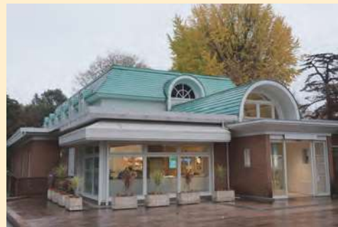
複雑な形状の屋根の防水工事は、場所ごとに改修の工法を変える設計をしました
