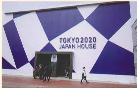
仮設パビリオン「日本館」(鉄骨造)
