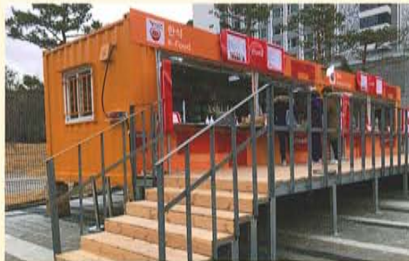
仮設店舗(コンテナ造)
