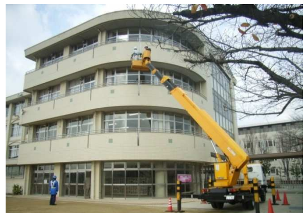
<高所作業車による外壁打診調査 作業風景>
