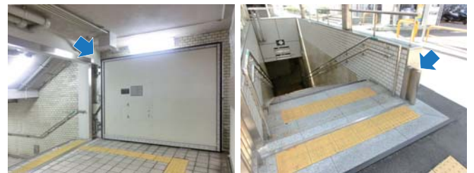
止水扉（撤去・新設）
