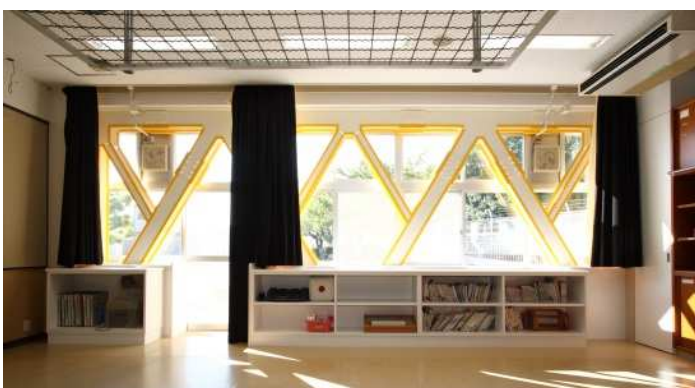
内観（鉄骨ブレース設置後）
