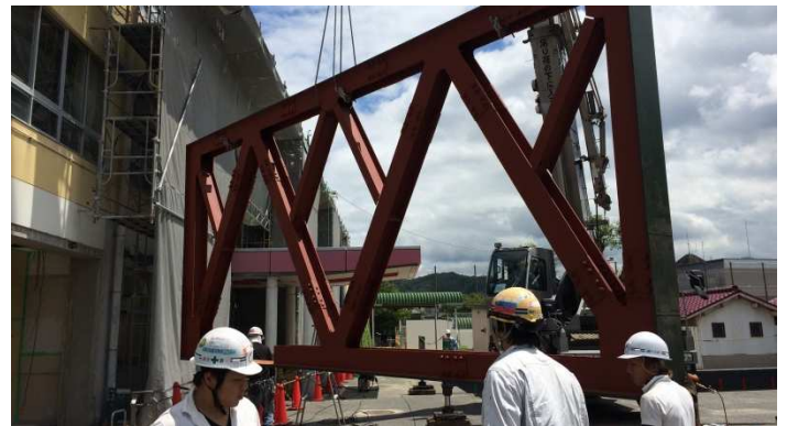
鉄骨ブレース設置作業風景
